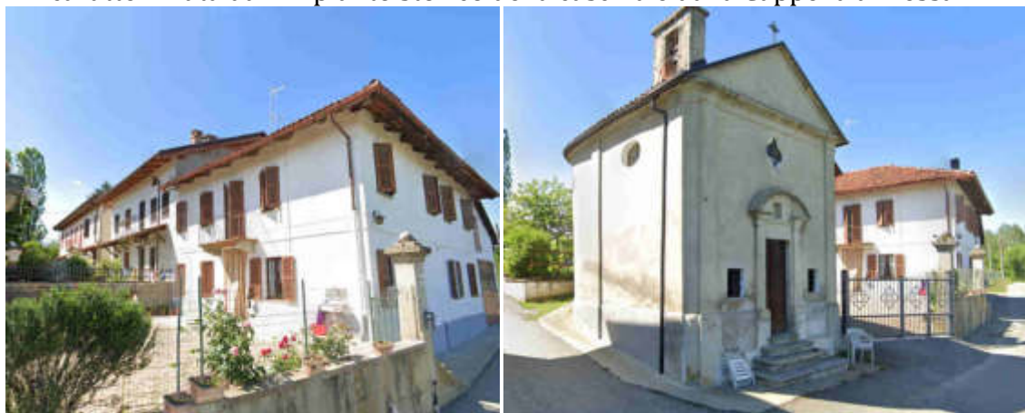
Cascina Asinara in Fraz Asinara di Rocchetta Tanaro
